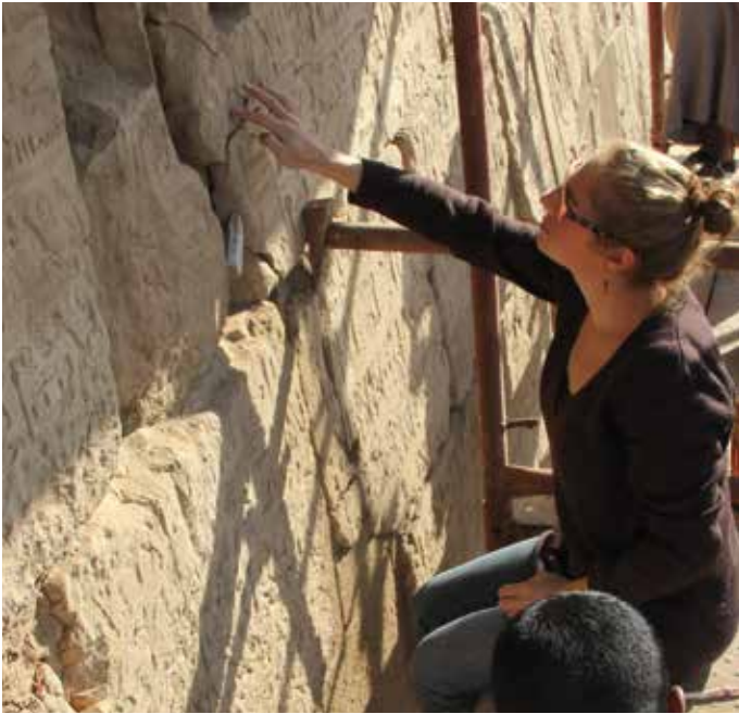
Restauration d'une paroi de temple
